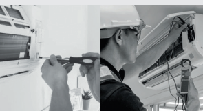
Raccordement électrique difficile
